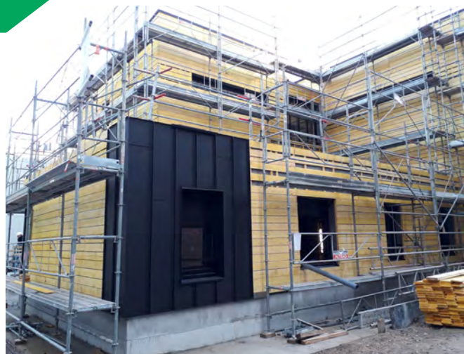
> La résidence « Meudon » à Boulogne-Billancourt prévoit une extension de 21 logements neufs en structure bois en juin 2019.
