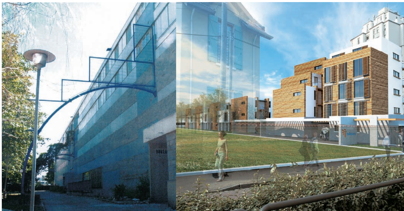
↑ Les réhabilitations menées dans le cadre du plan de traitement des foyers donnent un nouveau visage au logement très social.
